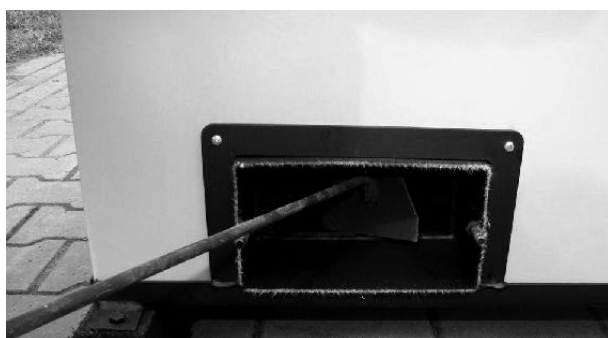
Czyszczenie wyczystki bocznej
