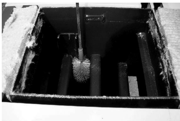
Czyszczenie kanałów konwekcyjnych
